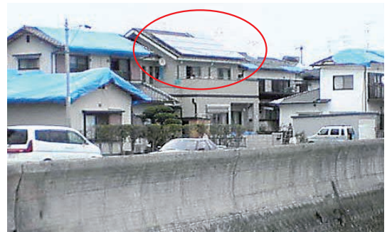
【台風通過後の当社施工宅】
