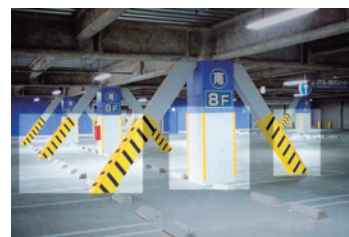
【駐車場での取付け】
