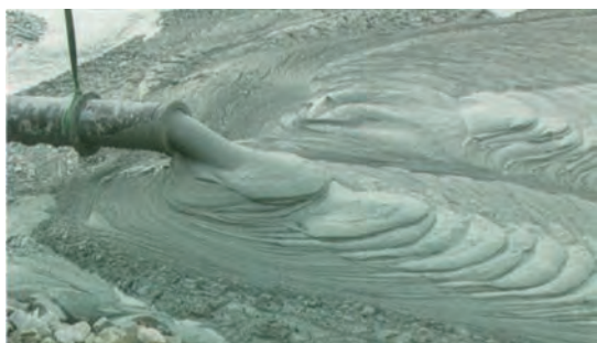
固化処理土打設状況 (圧送管先端部分)
