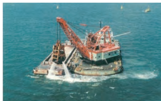
明石海峡大橋下部工事
