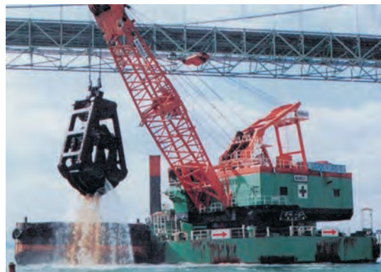
関門航路浚渫工事
