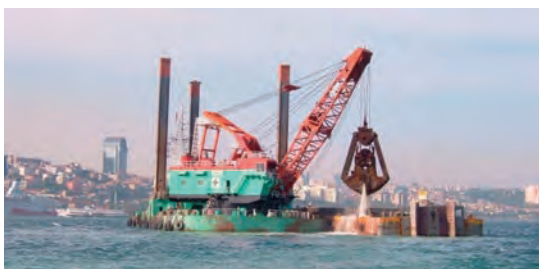
沈埋トンネル用トレンチ掘削（ボスポラス海峡）
